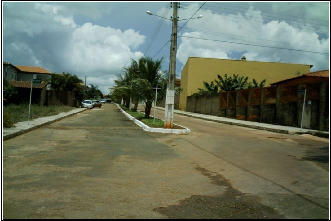
Figura 12: Condomínio 44 com infraestrutura construída pelos moradores. Fonte: foto do autor, Janeiro/2010.
