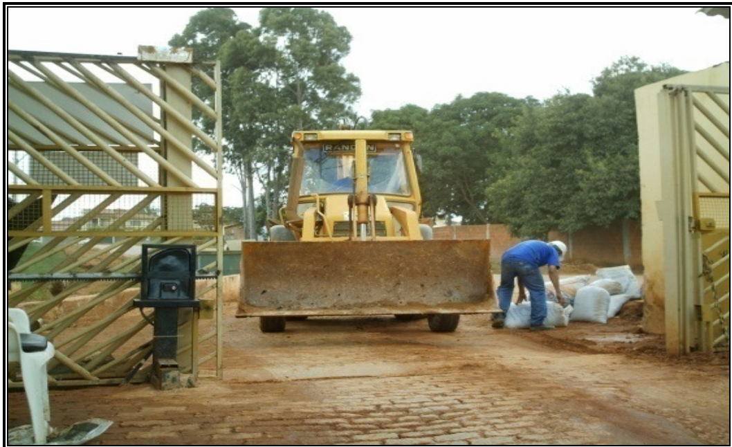
Figura 15: Implantação do Saneamento Básico realizado pela CAESB em Vicente Pires. Fonte: foto do autor, Janeiro/2010.
