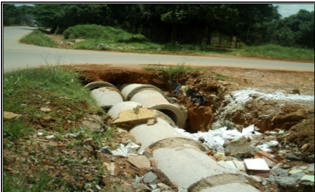
Figura: 09: Ruas 3 e 8- rede pluvial construída pelos moradores em Vicente Pires Fonte: foto do autor, Janeiro/2010.
