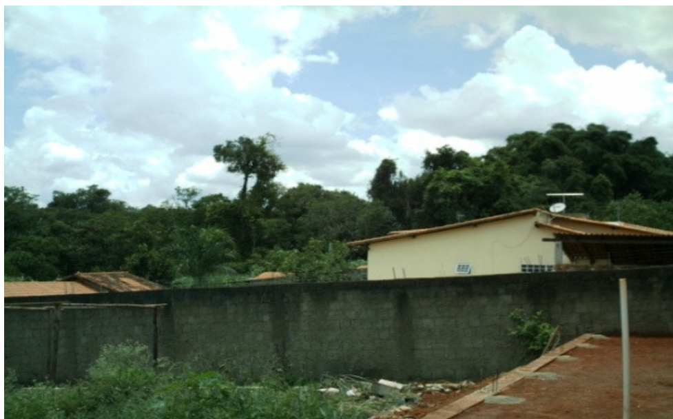
Figura 05: Construção próxima a mata ciliar na área de preservação (APP). Fonte: foto do autor, Janeiro/2010.
