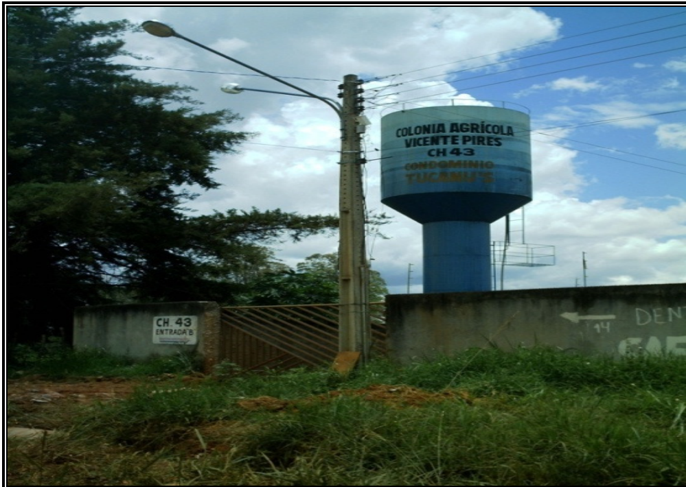
Figura 07: Poço artesiano em Vicente Pires. Fonte: foto do autor, Fevereiro/2010.
